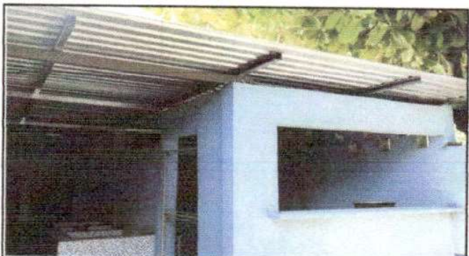
Foto 3: sustitución de lámina por lámina troquelada calibre 26 y estructura portante
