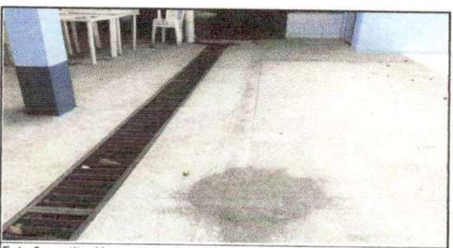
Foto 5: sustitución por torta de cemento y reparación de cuneta con parrilla de hierro más mano de obra
