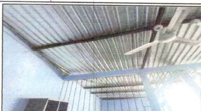
Foto 2: sustitución de lámina por lámina troquelada calibre 26
