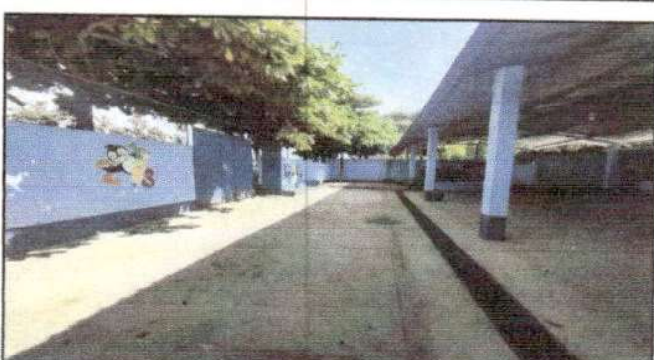
Foto 4: sustitución por torta de cemento y reparación de cuneta con parrilla de hierro más mano de obra
