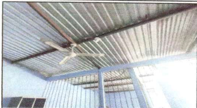
Foto 1: sustitución de lámina por lámina troquelada calibre 26
