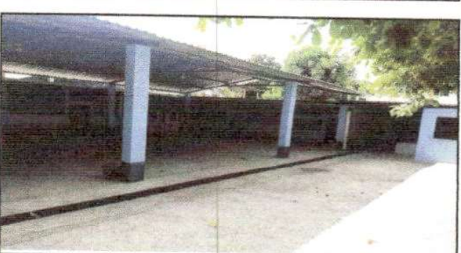
Foto 6: vista de la escuela de los trabajos realizados
